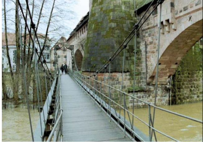
Kettensteg über die Pegnitz – innerhalb der Stadtmauer
